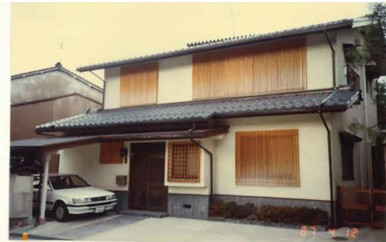
竣工当時の写真
